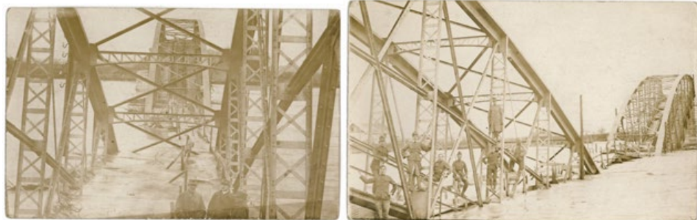
A felrobbantott vasúti híd roncsai (1920. január) Forrás: Tokaji Múzeum, TD 94.14, TD 94. 13
